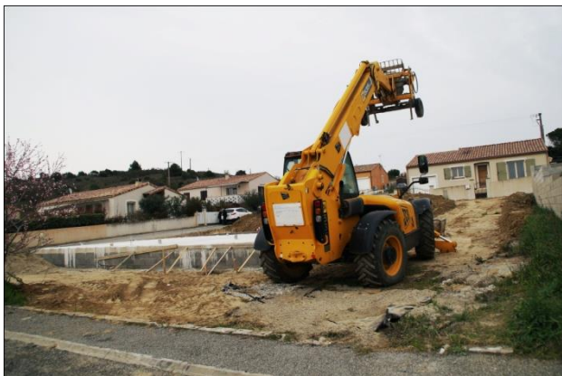
Photo 9 : Construction en cours au Prat
