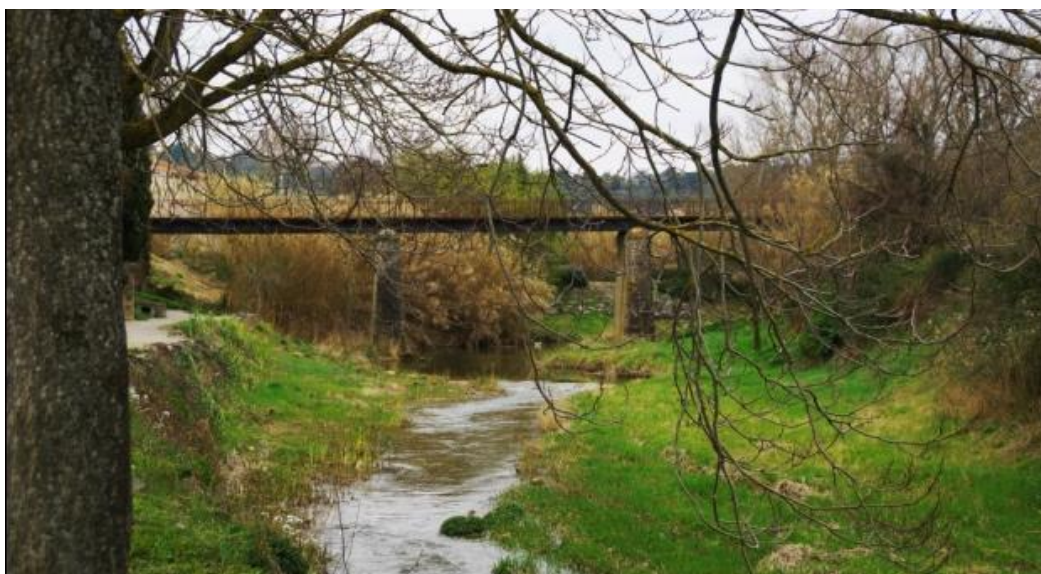
Photo 17 : Pont de la voie ferrée sur le Lauquet
