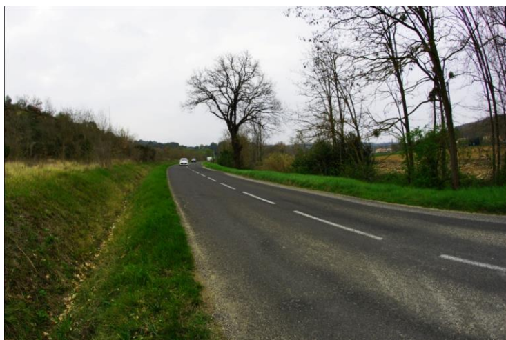
Photo 24 : Ripisylve dégradée du Lauquet (rive gauche)
