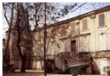
Façade arrière du château Niermans
