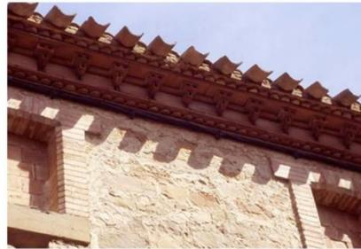
Corniche de toiture bâtie en briques cuites creuses et en carreaux festonnés (2, rue des Monts Lauriers)
