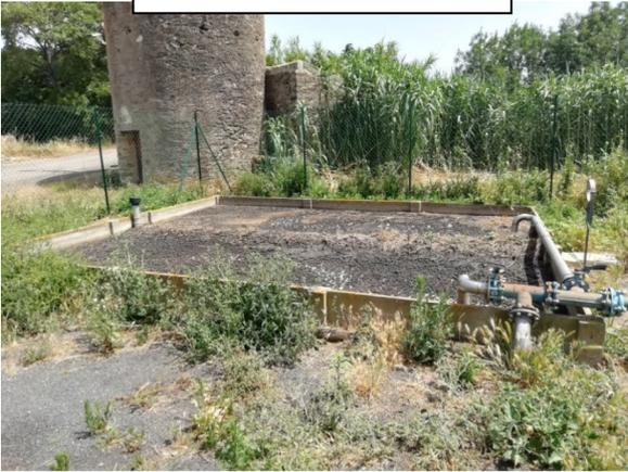
Lits de séchage de 28 m<sup>2</sup> (2u) (3 couvercles d'aération manquants)
