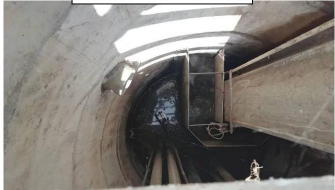
Bassin d'aération, clarificateur avec canalisation de recirculation et d'extraction
