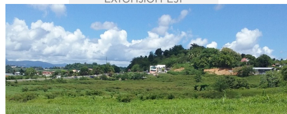
Vue sur l'extension Est
