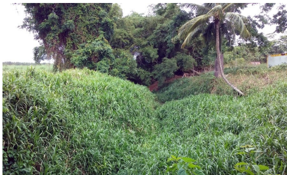
Canal d'irrigation non entretenu
