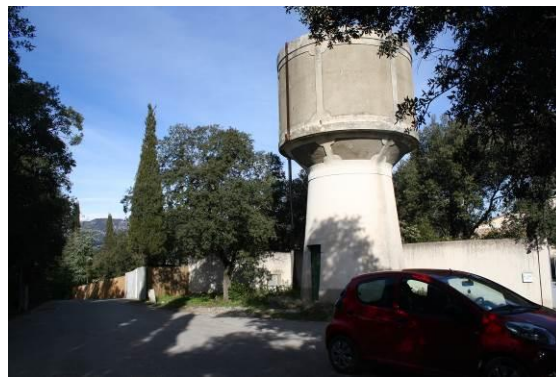
Photo 56 : Le château d'eau
