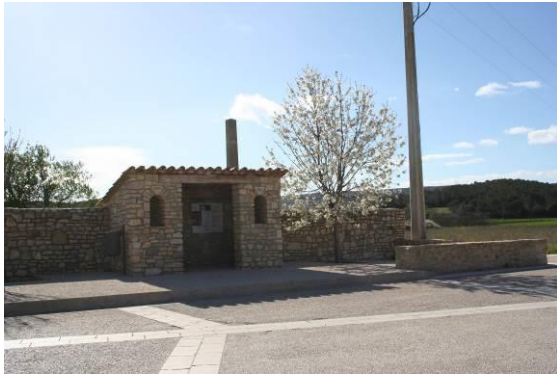
Photo 59 : Abri de bus à l'entrée du village (Allée de l'Hortus)
