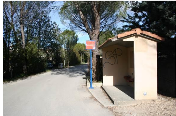
Photo 60 : Abris de à la « Roumanissière »
