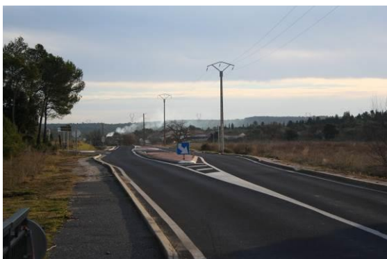
Photo 29 : La RD17 E3 en provenance des Matelles et le village du Triadou
