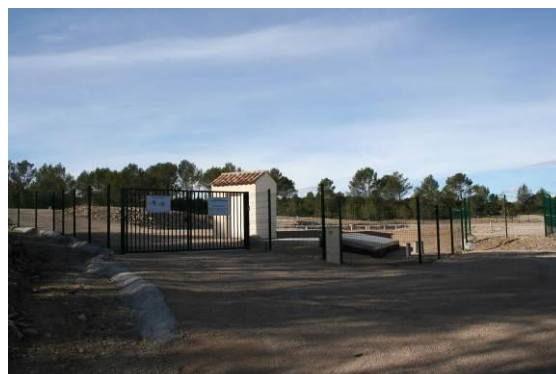
Photo 51 : La station d'épuration
