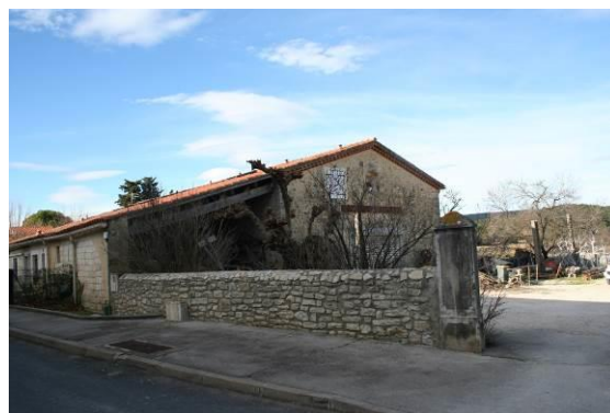
Photo 57 : Centre technique municipal
